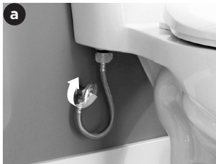
Gire la válvula de alimentación en sentido horario para cerrar el suministro de agua.
