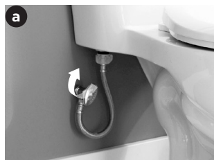
Fermer l'eau en tournant le robinet d'arrêt dans le sens horaire.
