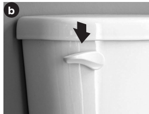
Descargue el inodoro para drenar el tanque. Utilice una toalla o una esponja para retirar el agua que quede.
