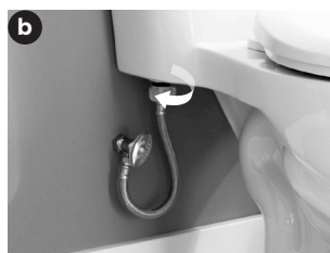
Dévisser manuellement l'écrou en le tournant dans le sens antihoraire et retirer la conduite d'alimentation. Si des outils sont nécessaires pour retirer l'écrou, utiliser une nouvelle conduite d'alimentation lors de la réinstallation.
